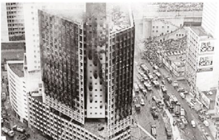
Em 1974, o Edifício Joelma, na capital paulista, foi tomado por um incêndio que tirou a vida de 187 pessoas, a partir de um curto-circuito no 12º andar
