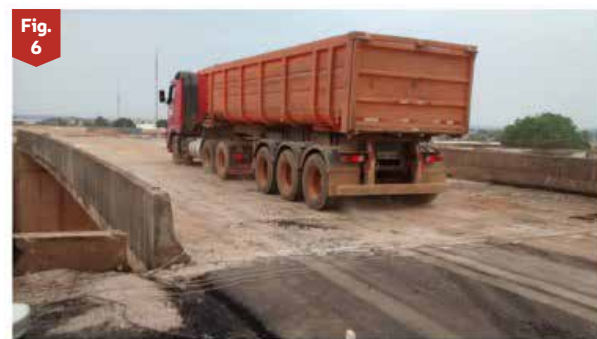
Ensaio de prova de carga em viaduto.
