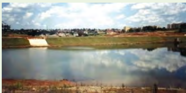
Figura 10 - Bacia de retenção
