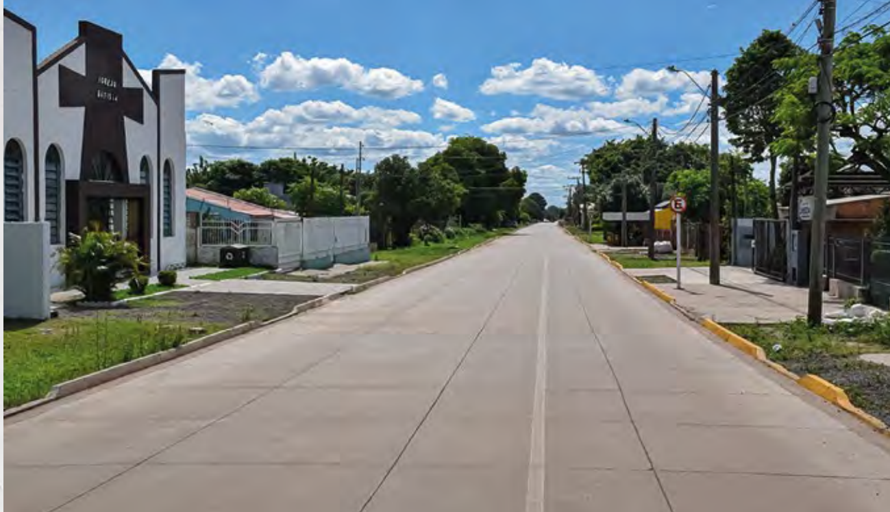
Pavimento de Concreto. Projeto realizado em Itaqui/RS
