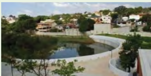
Figura 8 - Bacia de detenção
