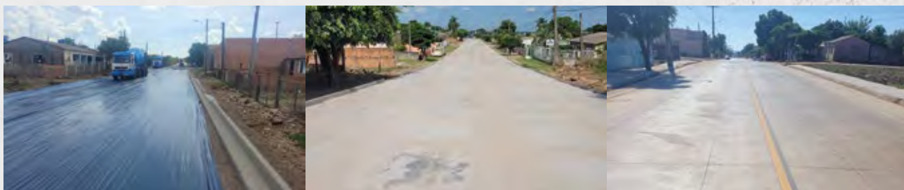
Pavimento de Concreto. Projeto realizado em Itaqui/RS
