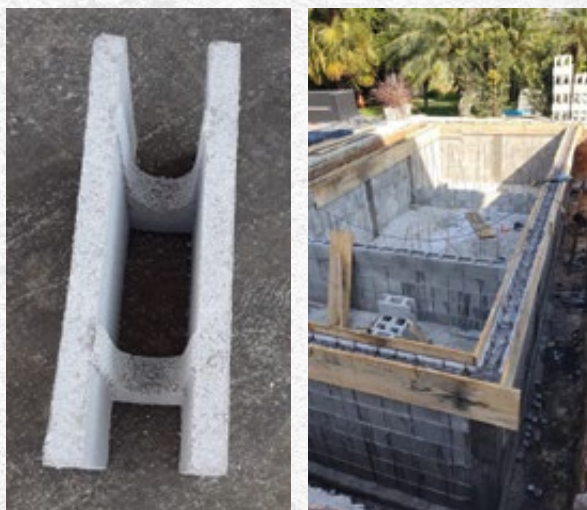
Figura 1 – Bloco estudado (a) e emprego do bloco de concreto (b).
