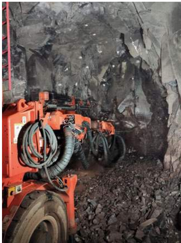
Figura 4 - Equipamentos de perfuração do túnel. Imagem: Schneider Engenharia.
