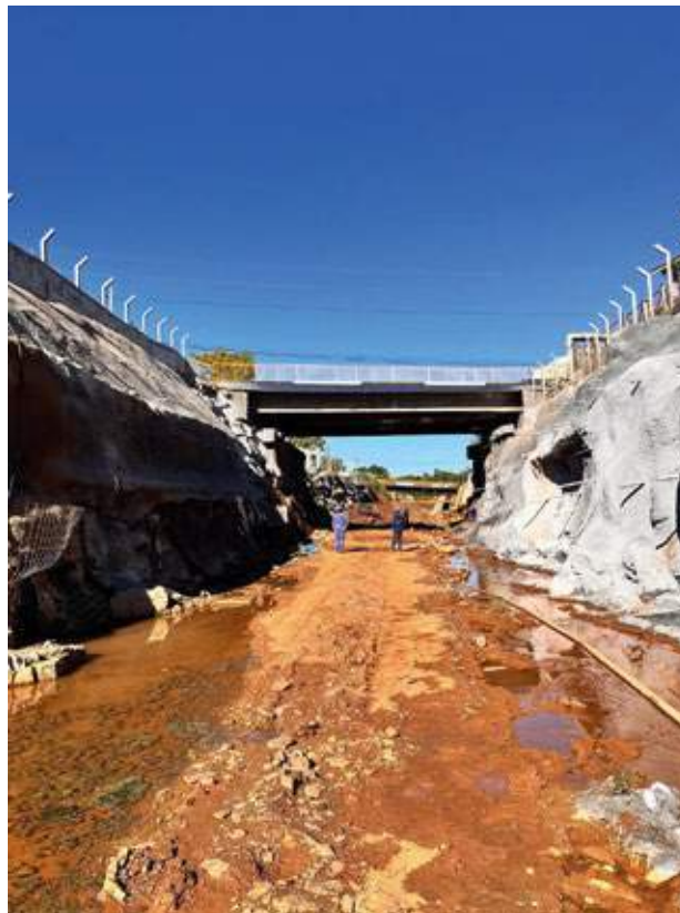
Figura 2 - Córrego Urutago. Imagem Schneider Engenharia.
