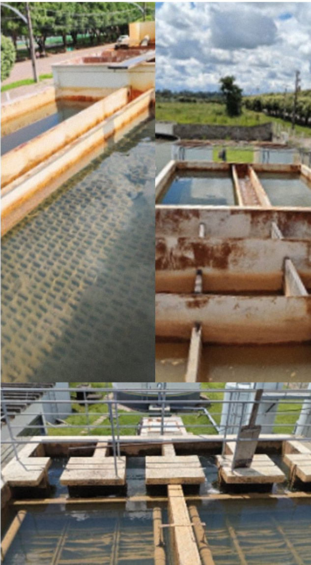
Figura 3: Estação de Tratamento de água de Paranaíta. Fonte: Autores (2025).
