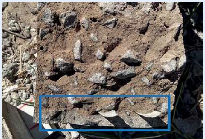
Figura 13 - Corpo de prova rompido com ênfase à interface de aderência entre as tiras de PRFV e o concreto
