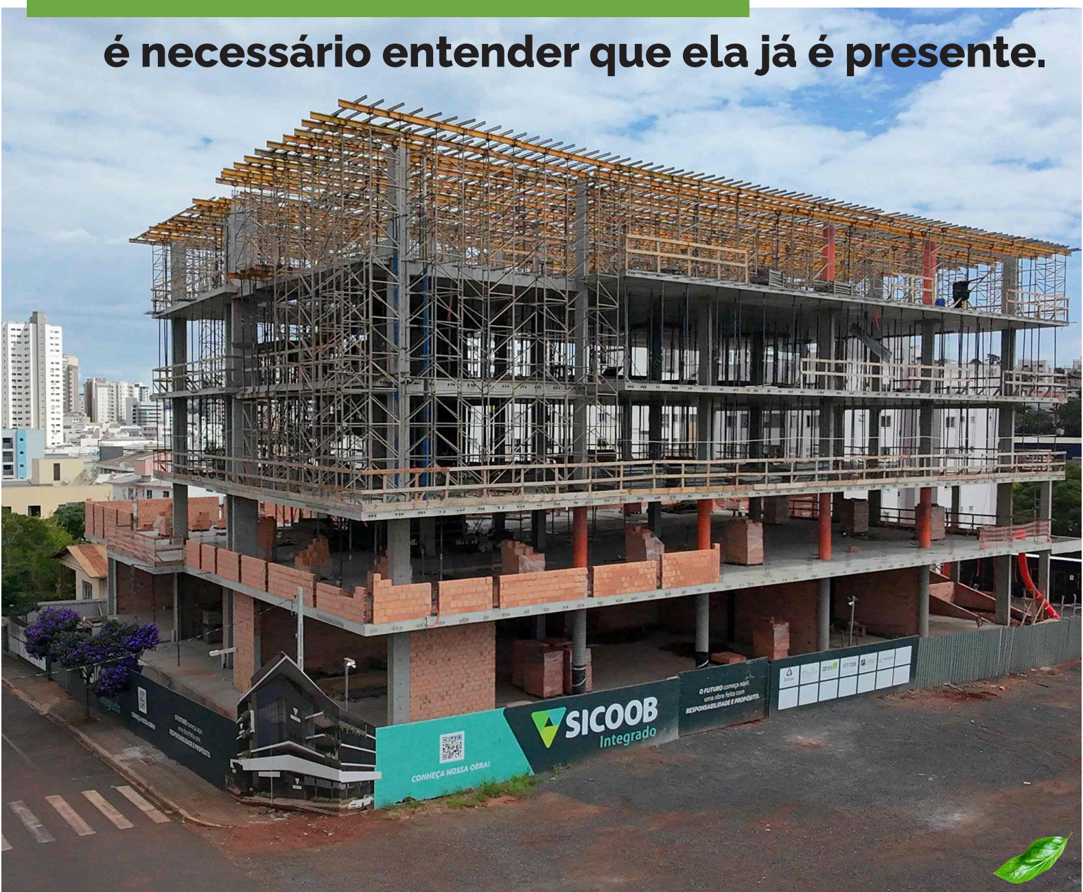
Unidade Administrativa Sicoob Integrado - Primeira obra em processo de Certificação LEED de Pato Branco-PR.
