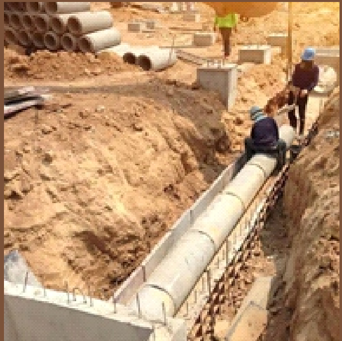
Figuras: Instalação subterrânea de sistemas de microdrenagem e saneamento profundo.
