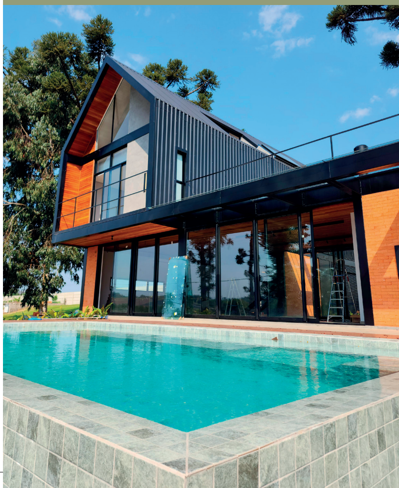
EXEMPLO DA CONSTRUÇÃO FINALIZADA - EXECUTADO PELA QUARTEL CONSTRUÇÕES
