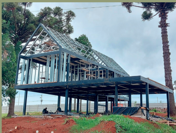
EXEMPLO ESTRUTURA EM LSF - EXECUTADO PELA QUARTEL CONSTRUÇÕES
