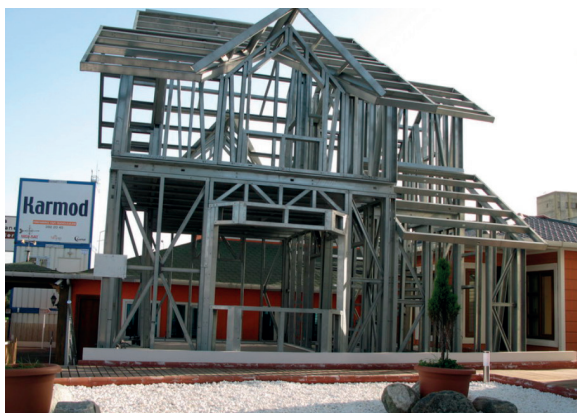
EXEMPLO DA ESTRUTURA COM PERFIL DE AÇO
