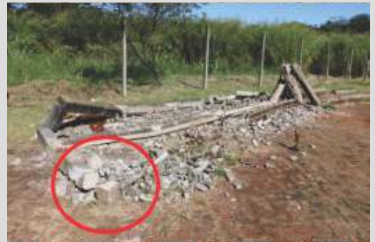
Figura 2 – Sinistro de pilar em um muro ornamental e de consolo pré-moldado. Fonte: SANTOS, 2022.
