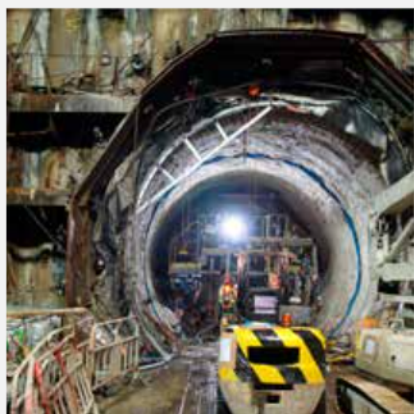
O planejamento de infraestrutura, como este túnel de metrô, é essencial para o desenvolvimento sustentável. © Sr. Pung Chun Nok, Instituto de Engenheiros de Hong Kong
