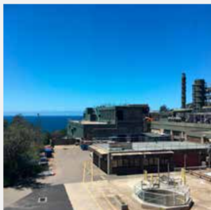
Biogás de esgoto tratado e utilizado para produzir eletricidade na North Head Wastewater Treatment Plant, em Sydney, Austrália. © Marlene Kanga
