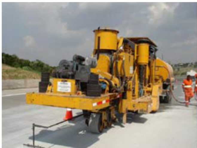
Micronivelamento do pavimento de concreto (Diamond grinding).
