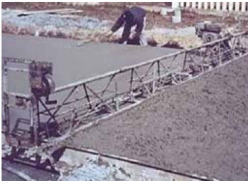
Pequeno Porte: Réguas /Trelças vibratórias Produção média: 100 a 200 m/dia.
