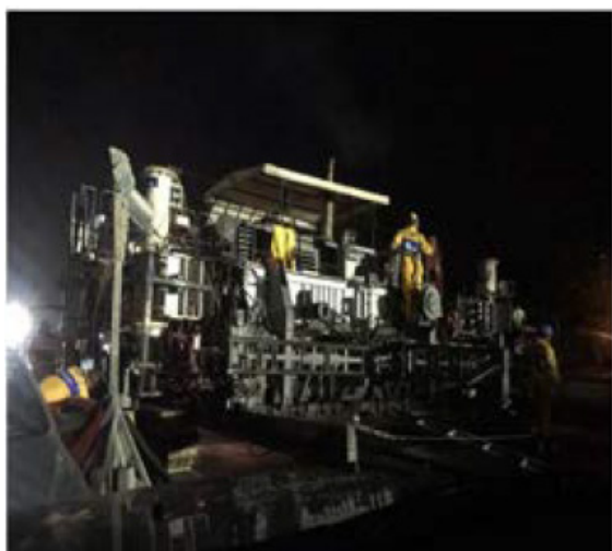
BRT Transbrasil - Rio de Janeiro/RJ - Execução com vibroacabadora de formas deslizantes, à noite.
