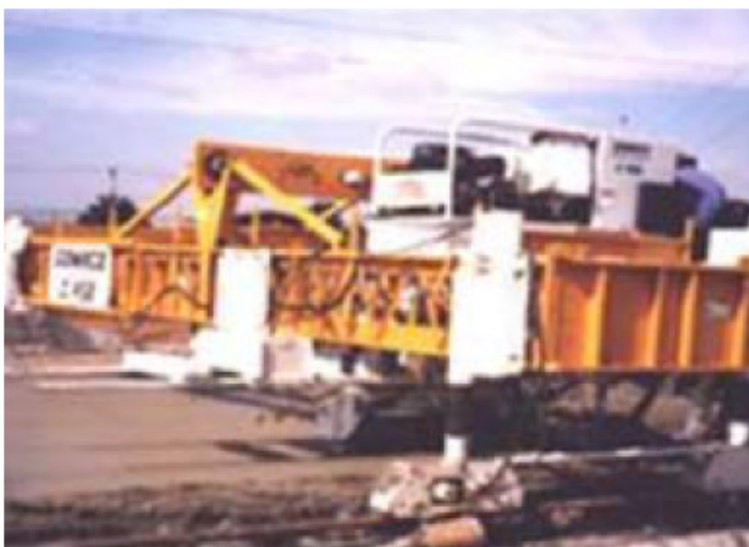
Formas-Trilho: Pavimentadoras de rolos vibratórios Produção média: 250 a 350 m/dia.
