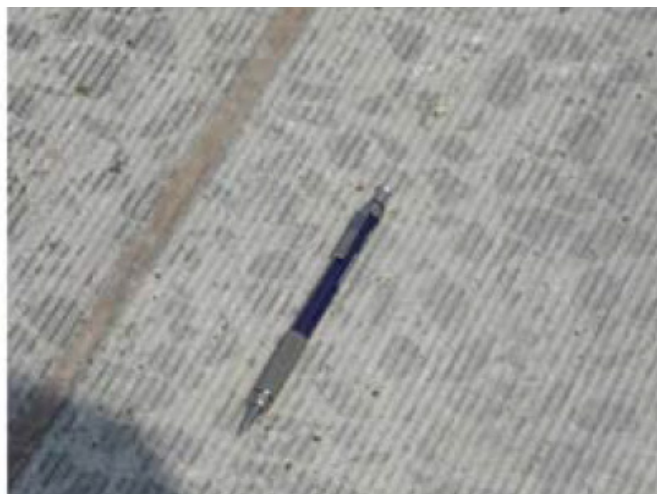
Micronivelamento do pavimento de concreto (Diamond grinding).
